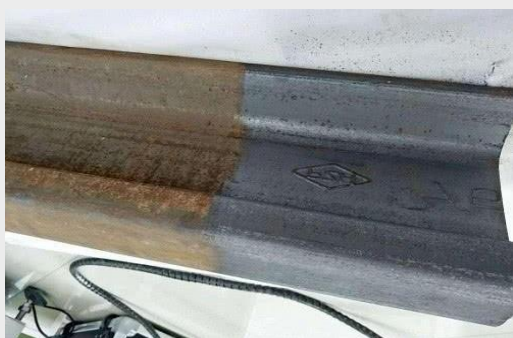
Limpieza de oxido en vías férreas de alta velocidad
