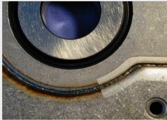
Limpieza de juntas de soldadura
