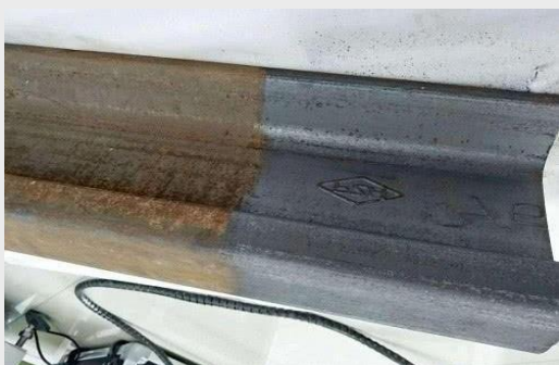
Limpieza de oxido en vías férreas de alta velocidad
